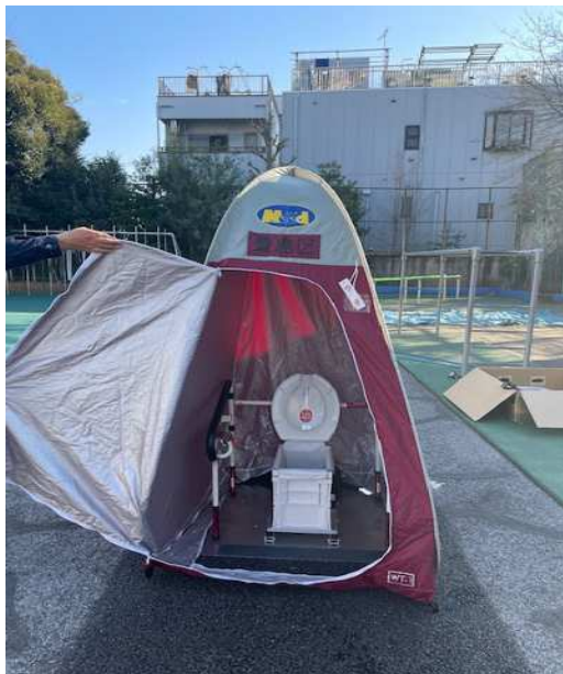
図 I-1 救援センター(避難所)に設置されるマンホールトイレ
