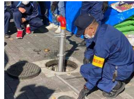
応急給水栓の設置
