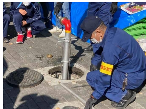
応急給水栓の設置
