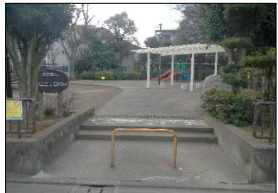
バリアフリー化されていない公園東側出入口
