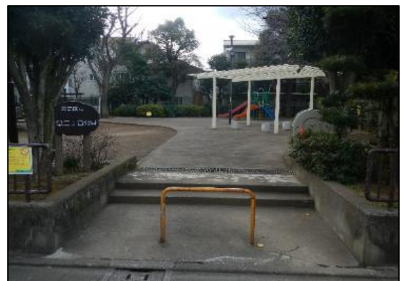
バリアフリー化されていない東側出入口
