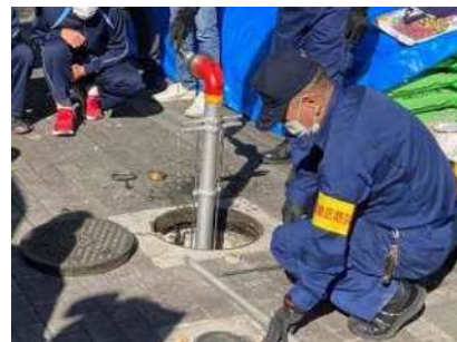
応急給水栓の設置
