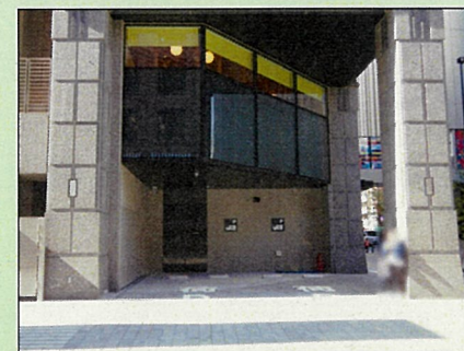
① ときわ区民センター共同荷さばきスペース
