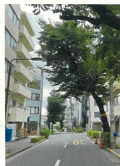
幹の車道へのせり出し
