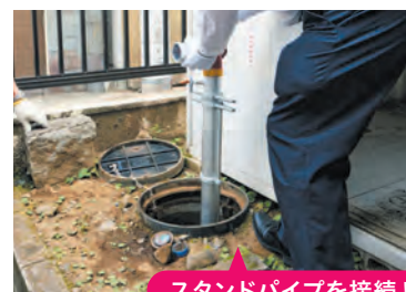
スタンドパイプを接続！
