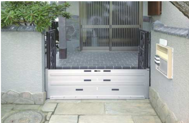
止水板設置工事の例
