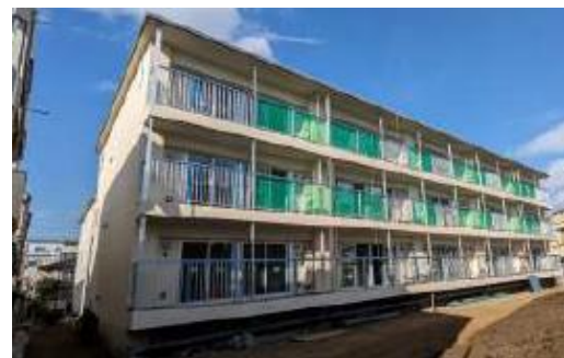
② 千早四丁目アパート全面改修後（1号棟）
