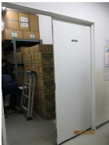
【南池袋小学校ミニ備蓄倉庫の内開き扉】
