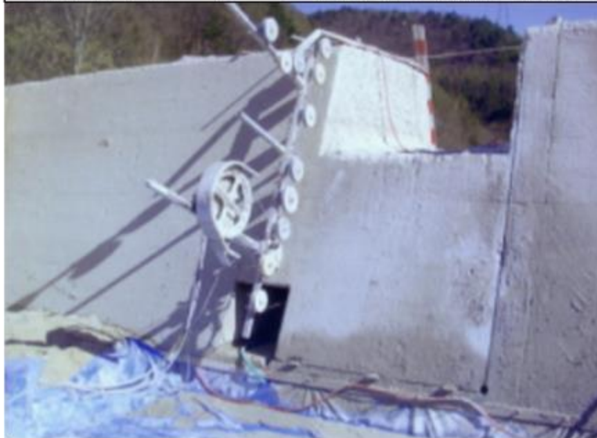
例)ワイヤーソー：コンクリート切断写真
