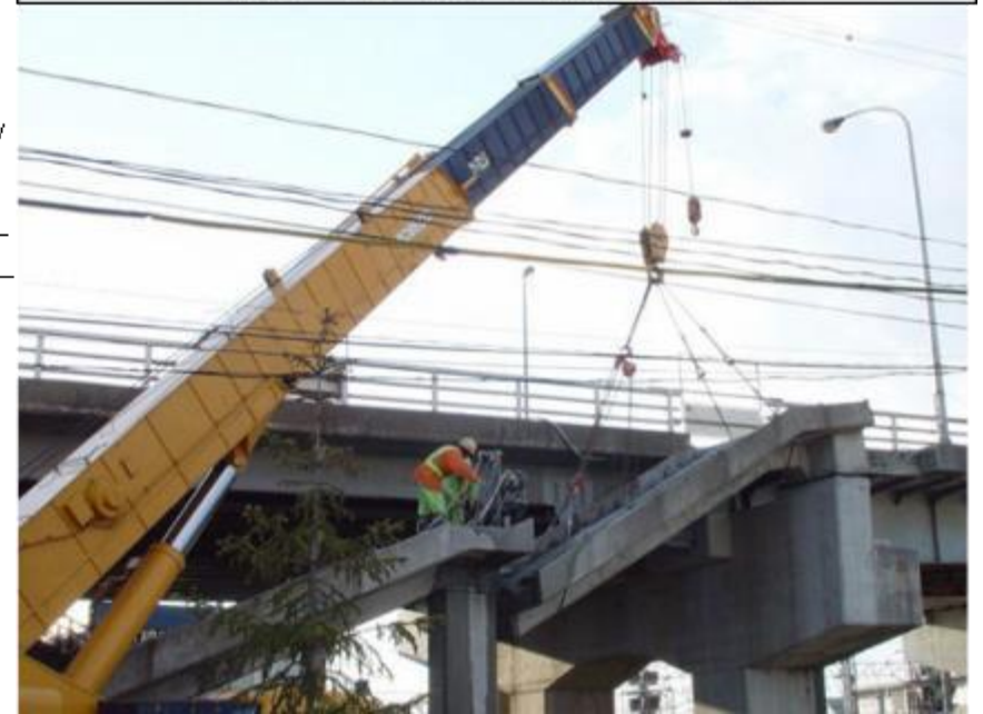
例) コンクリート撤去写真
