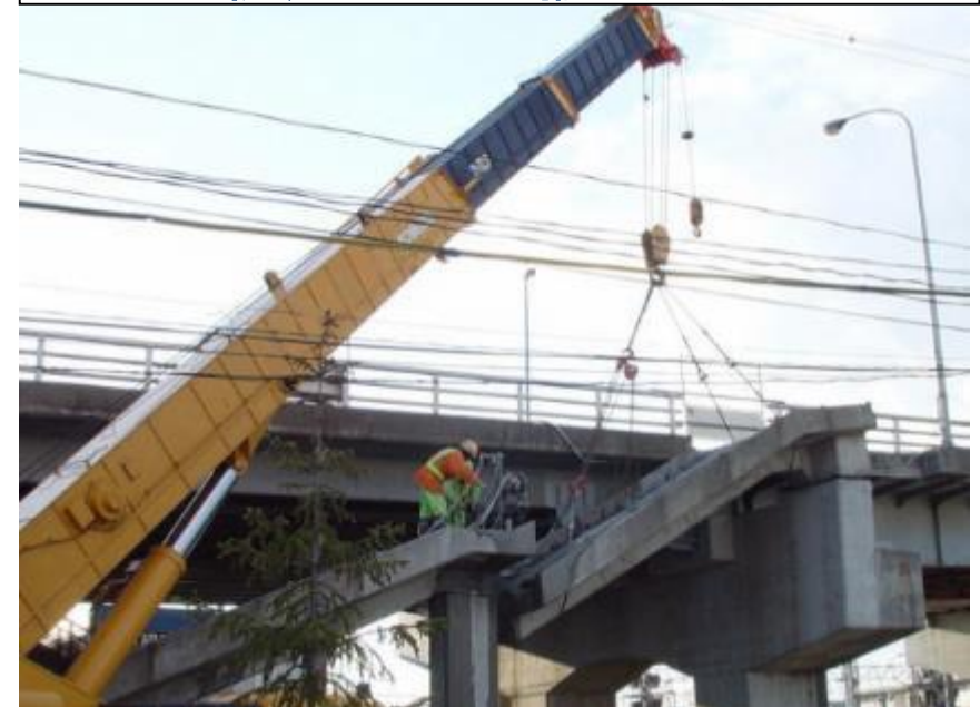
例) コンクリート撤去写真
