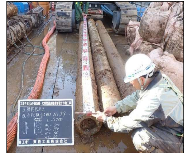
引き抜きされた杭
