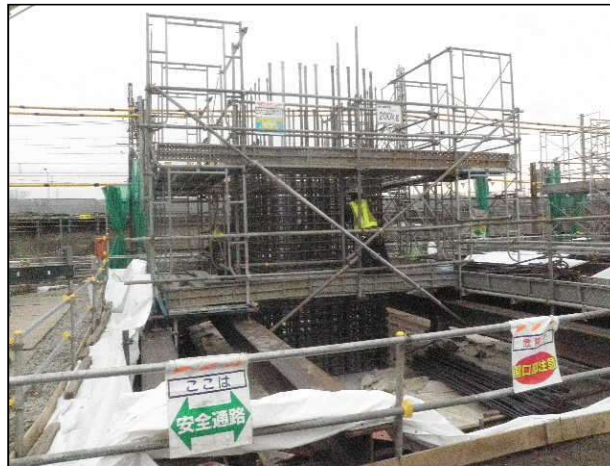
②鉄筋組立・型枠設置
