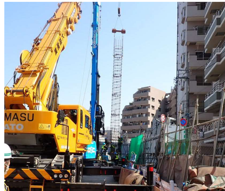
鉄筋建込状況
