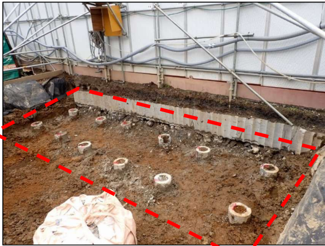
擁壁撤去後 (直下に杭出現)
