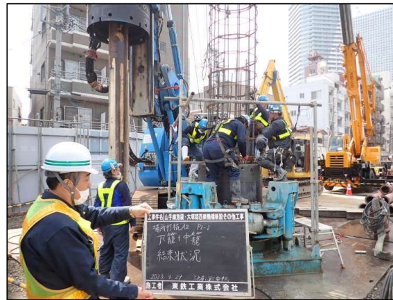
②鉄筋挿入
