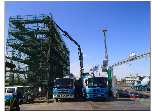
③コンクリート打設
