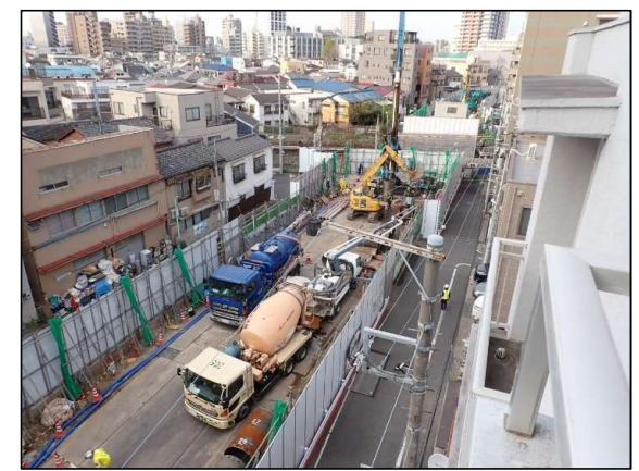
③コンクリート打設
