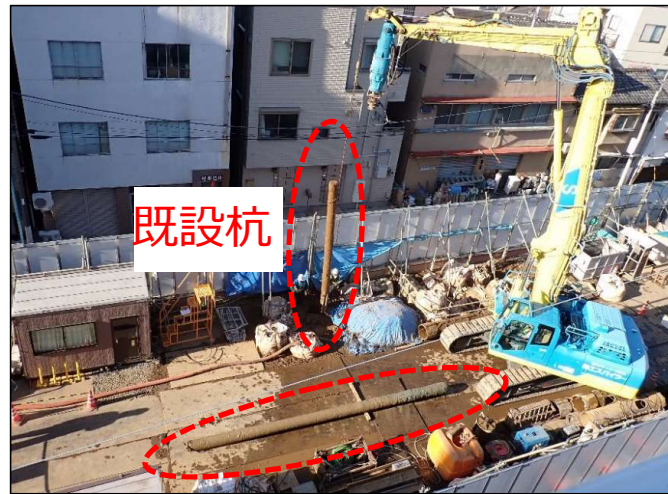
杭引き抜き施工
