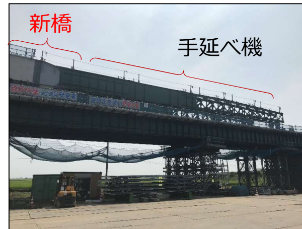
橋の組立（作業台上）
