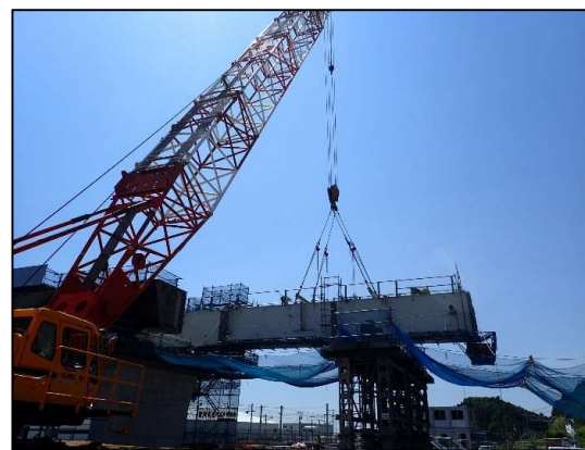
橋設置状況②
