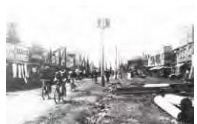
図表10 現春日通りの拡幅工事 (昭和2(1927)年)
