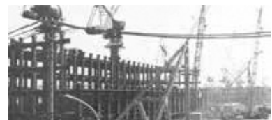
図表18 工事中のサンシャイン60（昭和51（1976）年頃）
